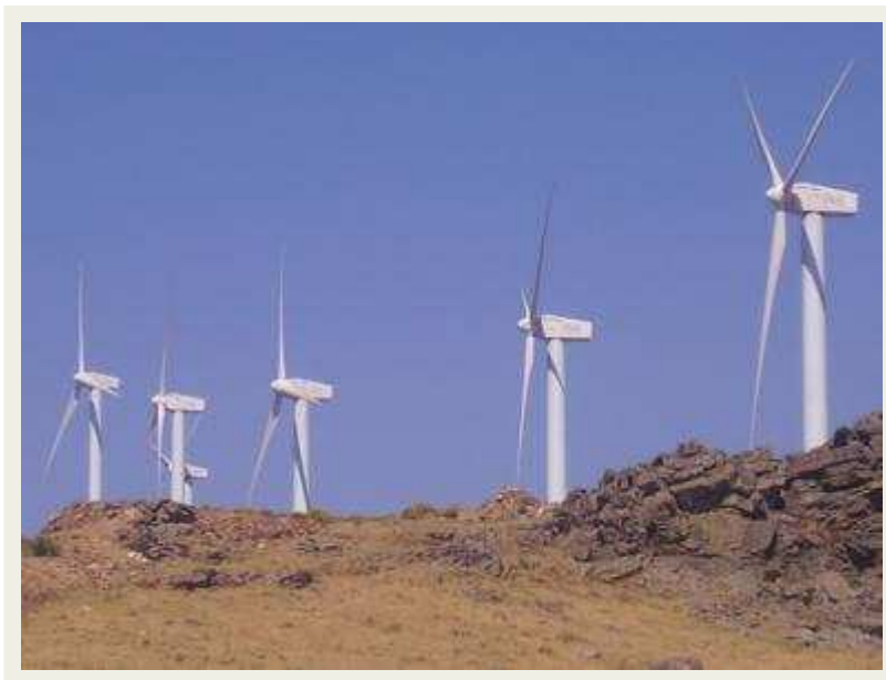
Generadores de un parque eólico
